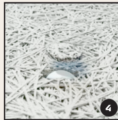
Placera de borrarade bitarna av cementbunden träull i hålen med tätningsmedel
