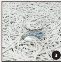
Skär till den cementbundna träullen och fyll hålet med den
